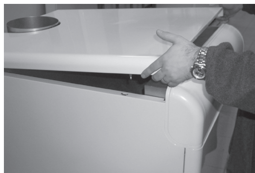
Fig. 7 - Soulever le couvercle (fixé par des goujons encastrés) du manteau en exerçant une pression de bas en haut.
